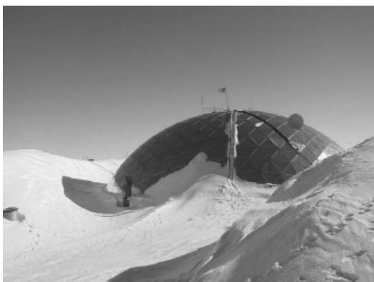
Главное здание станции, The Dome
