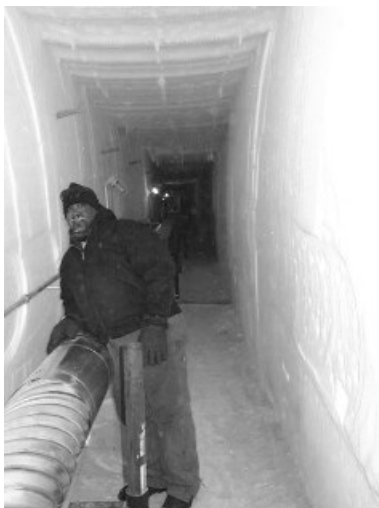
Тоннель с прямоугольным сечением. Эти вогнутые стены вначале были прямыми: лед течет, куда может
