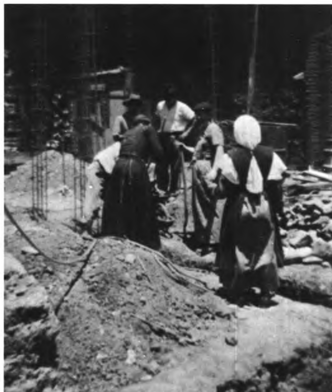
Иг. Веніаминъ и сестры обители за работой при постройкѣ церковнаго дома.
