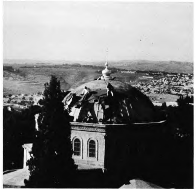
Ремонтъ купола храма Вознесенія.
