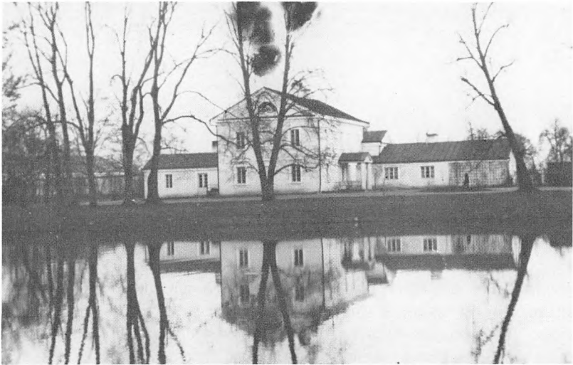
Щорсы. Отстроенная часть дома.
