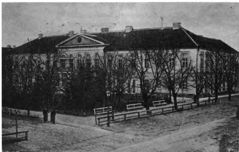
Здание Маринского Донского Института в Белой Церкви.
