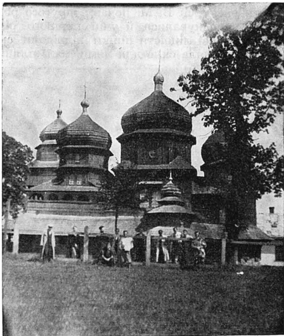
Лицїсти під церквою св. Юра. Церква св. Юра в Дрогобичі, яку перевезено з Києва й яка має понад 400 лїт. Зроблена без жодного залїзного цвяха.
