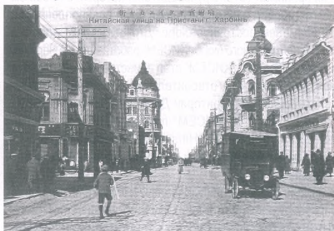
Ул. Китайская, угол Конной
