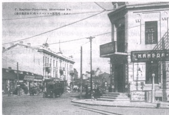
Ул. Мостовая, угол Китайской
