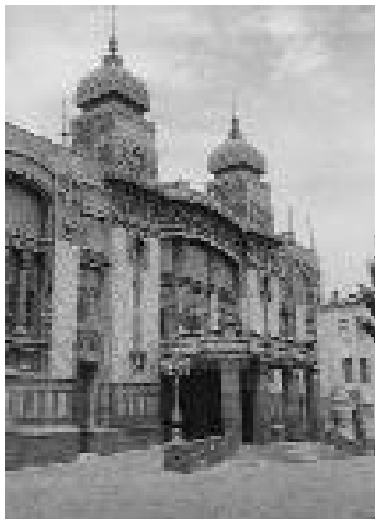
Театр оперы и балета после реконструкции.
