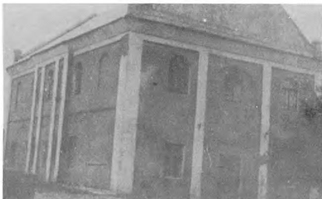
Здание бывшей синагоги в г. Шепетовка, Украина. В настоящее время – спортивный клуб. Май 1982 г.
