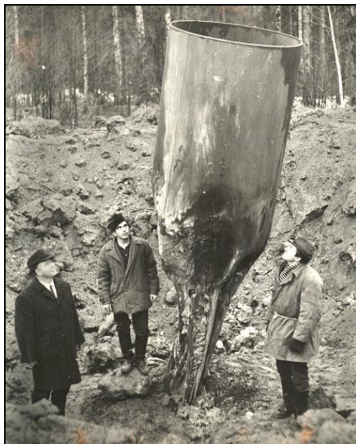
Испытание взрыв-затвора для перекрытия канала вывода излучения при подземных ядерных взрывах. На снимке: М.Н. Павловский, И.Е. Лобанов, Н.Г. Калашников. Саров. 60-е гг.
